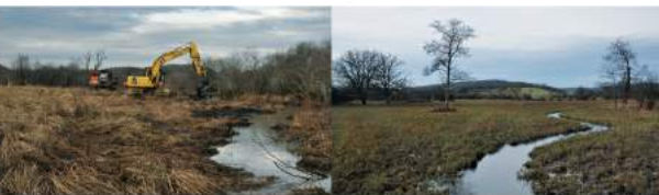
2012 : la Noue Rouge pendant les travaux de restauration
