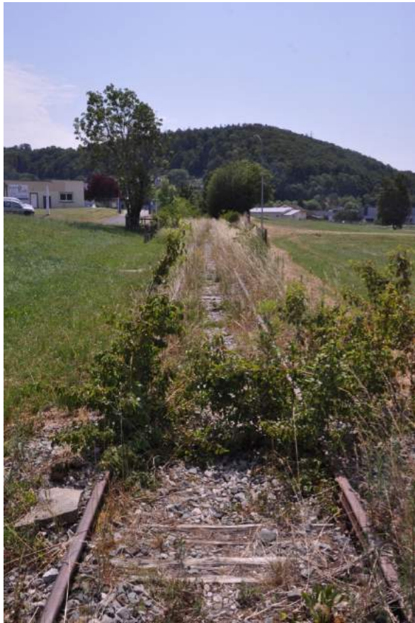
Figure n°1 - Voie désaffectée vers le Cuchot, à Pont-de-Roide (C. Hennequin).
