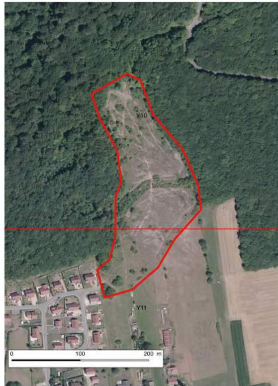
Figure n°3 - Photo aérienne de la zone d'étude ©IGN-BDORTHO2013.
