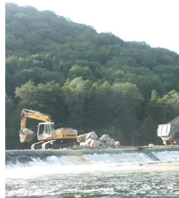
Figure n° 20 : travaux d'intervention sur un seuil du Doubs en moyenne vallée (M. Vuillemenot, Clerval [25]).
