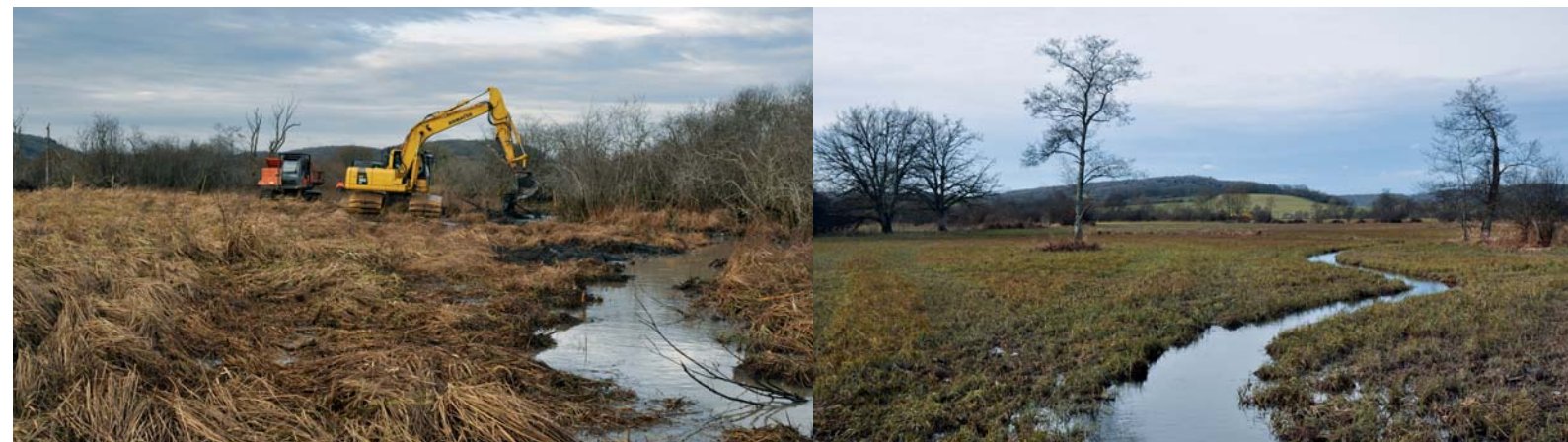
2012 : la Noue Rouge pendant les travaux de restauration
